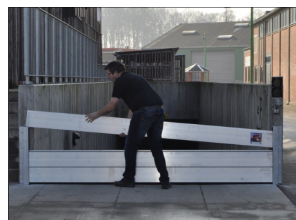
Bjælkerne, der beskytter P-kælderen, lægges hurtigt til rette mellem de fastmonterede profiler. De er ca. 325 cm lange og vejer hver kun 13,4 kg.
