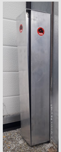
Grundprofilernes gummilister beskyttes mod sol og mekanisk påvirkning med en afdækning
