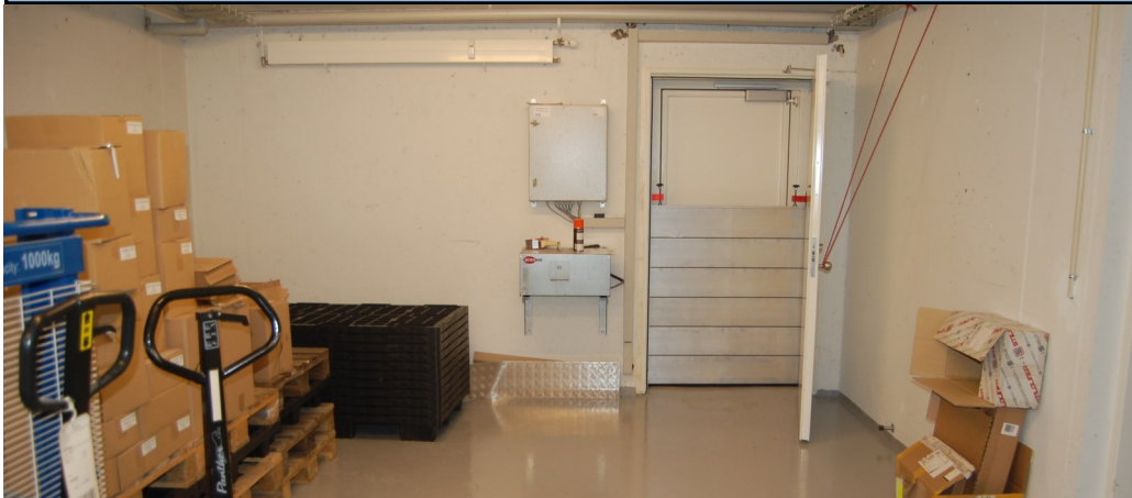
Forskellige tiltag skal sikre de opbevarede varer i kælderdepotet mod oversvømmelse - vandbarrieren er et af dem.
